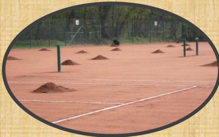
PÁLYAFELÚJÍTÁS / ÚJ SALAKKRÉTEG - MÁRCIUS
